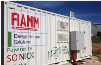
Batteries : 1,6MW x 3h / 18 kW x 3h
